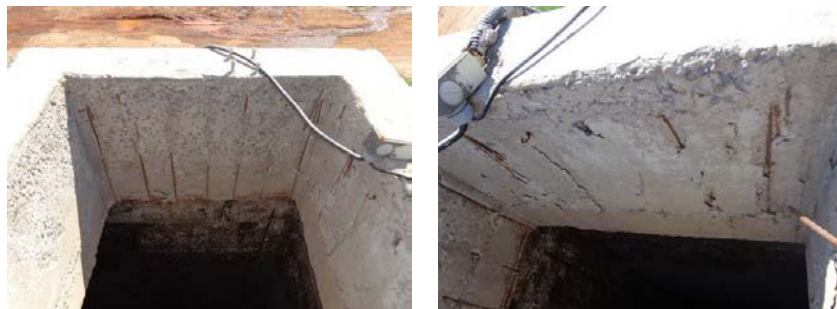
Figura 8: Paredes laterais das aberturas do Tanque de Armazenamento de Lodo
