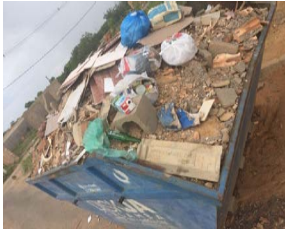
Figura 3: Caçamba para disposição de RCC. Fonte: autores (2017).
