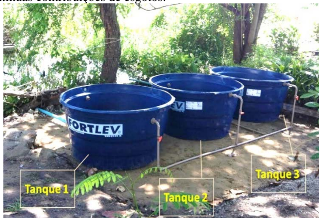
Figura 2: Sistema de tanques montado na UFCG Fonte: GALISA, 2016
