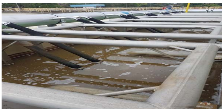
Fotografia 3- Skid com membranas submersas em água suja devido ao processo de limpeza das membranas.
