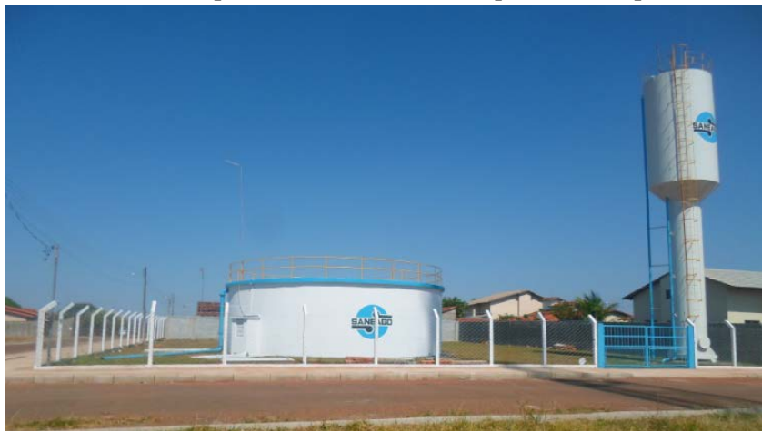
Figura 2: Reservatório apoiado e elevado do município de Terezópolis – GO.
