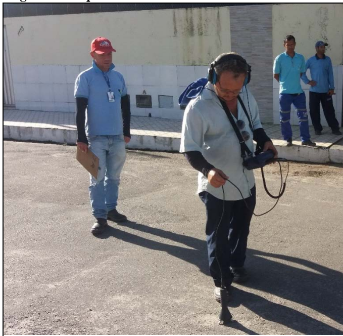
Figura 8. Pesquisa de vazamentos com Geofone Eletrônico
