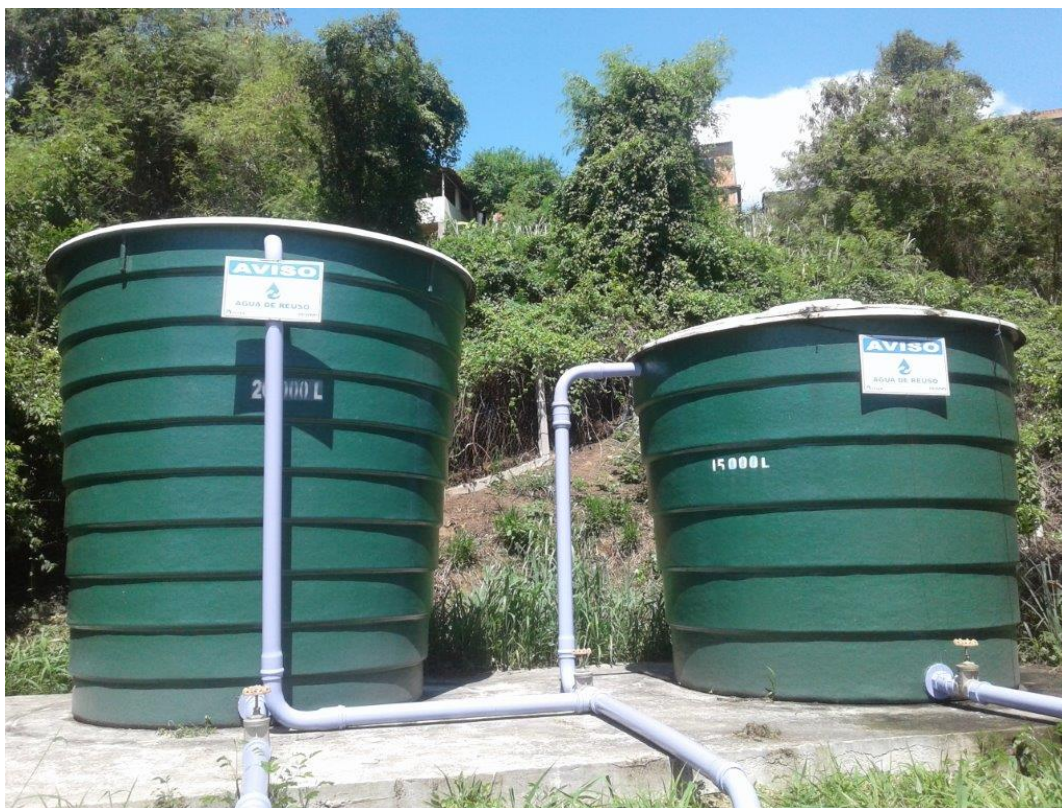
Figura 3. Reservatórios de água de reúso instalados na ETE Bandeirantes. Fonte: O autor (2019).
