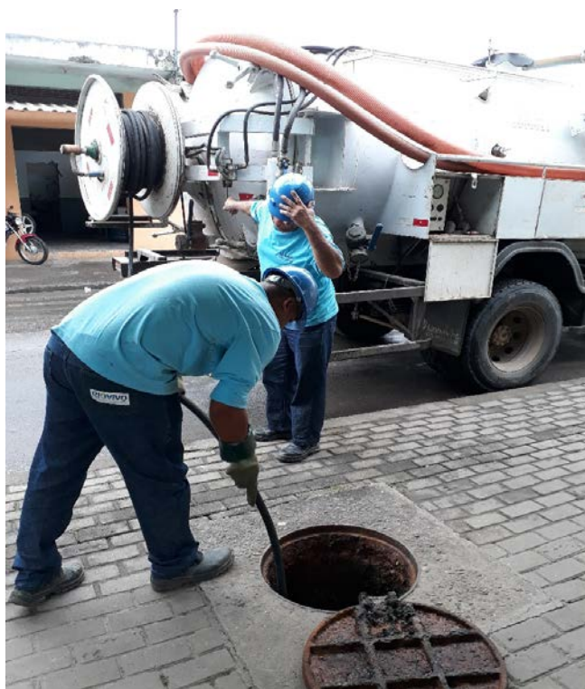
Figura 6. Desobstrução de rede de esgoto da Companhia com água de reúso. Fonte: O autor (2018).
