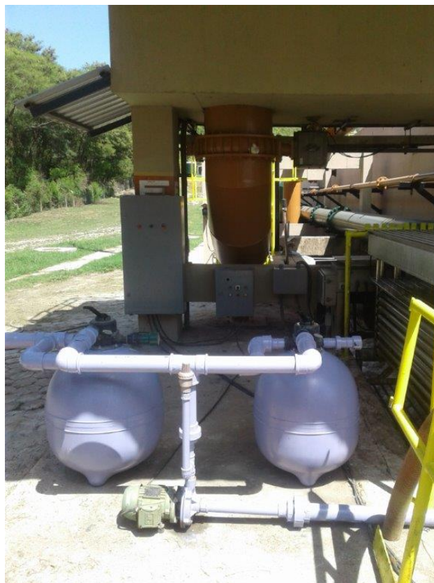
Figura 2. Sistema de polimento de efluente da ETE Bandeirantes. Fonte: O autor (2019).
