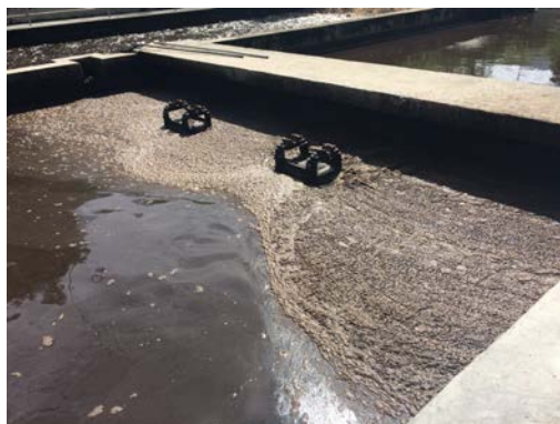
Figura 3: Presença de espumas no valo de oxidação.
