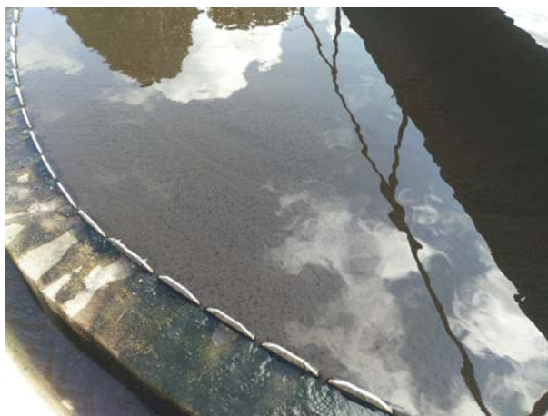
Figura 5: Intumescimento ocorrido no decantador secundário.
