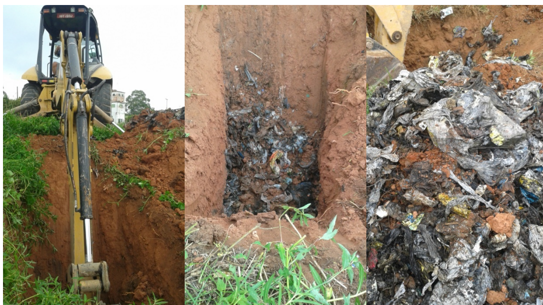
Figura 1: Remoção da amostra de RSD com auxílio de Retroescavadeira
