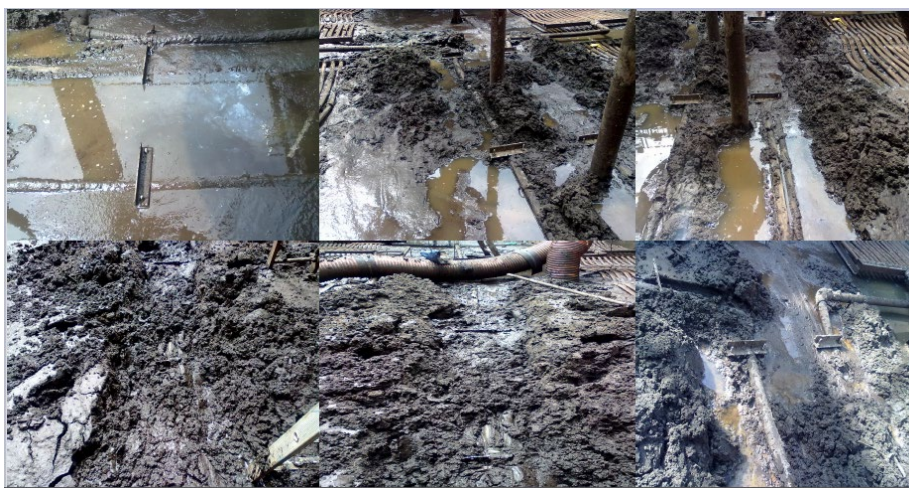
Figura 6 - Excesso de areia carregada pelo sistema de esgotamento da cidade de Mongaguá/SP/Sabesp – ETE Barigui (Fonte Sena 1 )
