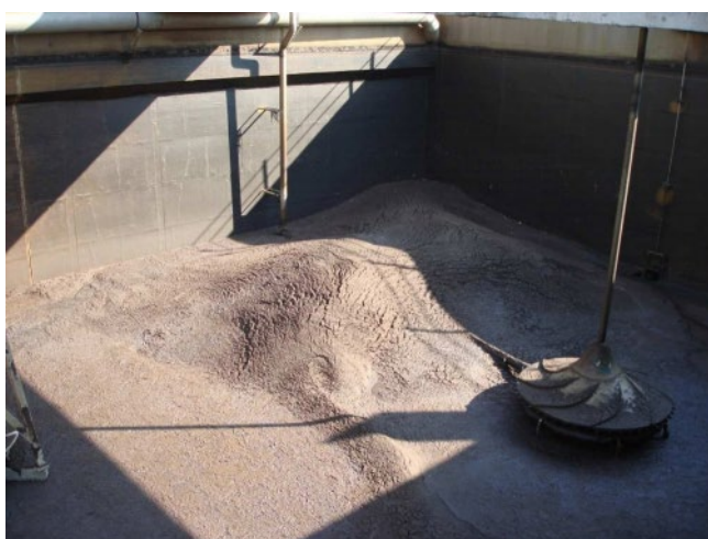
Figura 4 - Acúmulo de areia no tanque de aeração – ETE Limoeiro (ABES, S/D)
