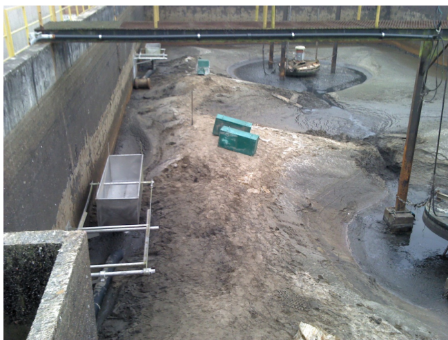
Figura 3 - Acúmulo de areia no tanque de aeração – ETE Bertioga 1 - (Fonte Sena 1 )
