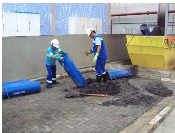
Figura 5 – Excesso de areia carregada pelo sistema de esgotamento da cidade de Mongaguá/SP/Sabesp – ETE Barigui (Fonte Sena 1 )
