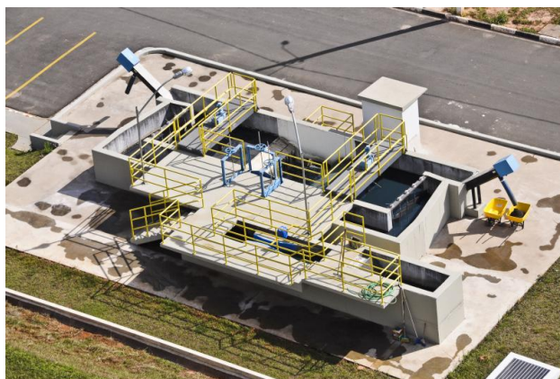
Figura 1 - Sistema de remoção de areia - convencional
