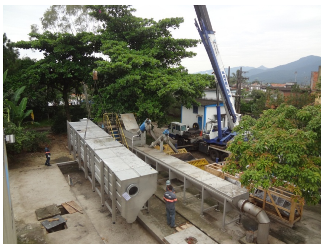
Figura 2 - Sistema compacto de remoção de material sólido e areia - Vibropac (Fonte: Sena 1 )
