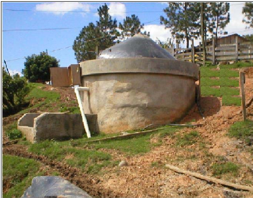
Figura 4: Biodigestor de lodo operado
