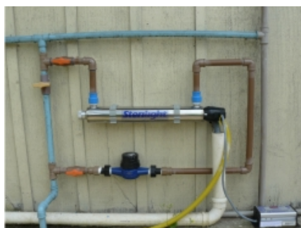
Figura 5: Sistema de desinfecção por radiação UV e hidrômetro para medição do consumo.
