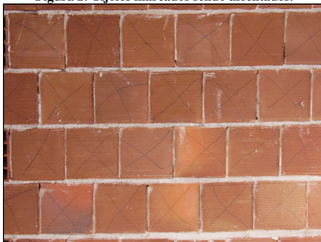
Figura 3: Tijolos marcados assentados.
