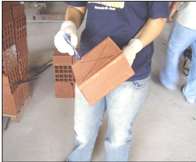
Figura 1: Marcação dos tijolos a serem assentados.
