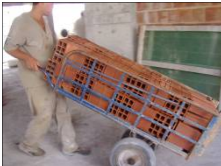
Figura 4: Transporte de pallet para o pavimento tipo: (a) Transporte vertical por meio de grua; (b) Transporte horizontal através de carro de mão.
