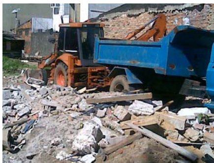
Figura 3 - Caçambeiro de Empresa privada entregando o RCDS
