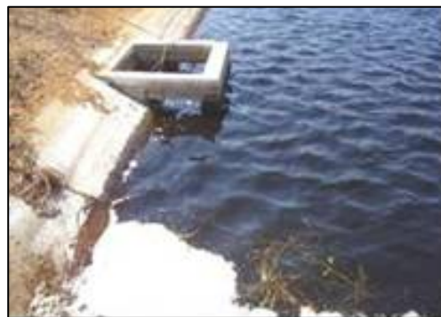
Figura 1b. Vista da saída da lagoa facultativa onde se coletava o efluente tratado.
