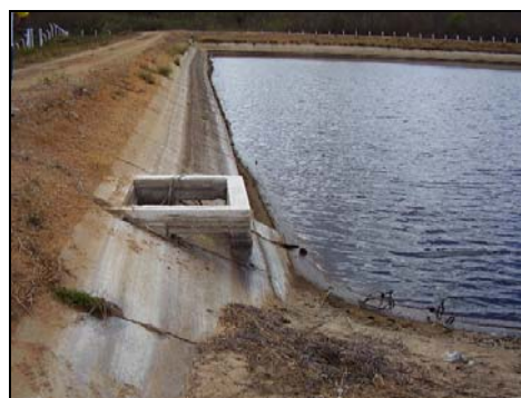
Figura 2b. Vista do nível da lagoa facultativa em nov/07.
