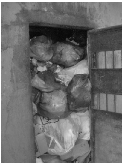
Figura 2: Armazenamento externo inadequado de acordo com a norma NBR 12.235. Mistura de Resíduo do (Grupo A) e do (Grupo D), acima do permitido pela capacidade. Ampliando os Riscos de Proliferação de agentes patogênicos e acidentes no trabalho.
