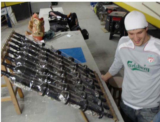
Figuras 8 e 9: Montagem do coletor Fonte: SANTANA, 2009
