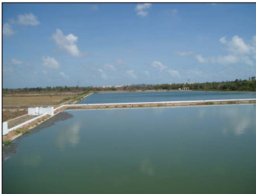
Figura 1 – Vista do sistema de lagoas de estabilização em série. Aquiraz, CE. 2007.
