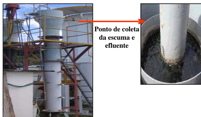
Figura 1: Vista do reator UASB e decantador ampliado à direita.
