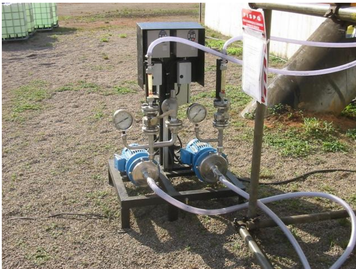
Figura 1: Sistema simples de dosagem de peróxido de hidrogênio em redes de esgotos
