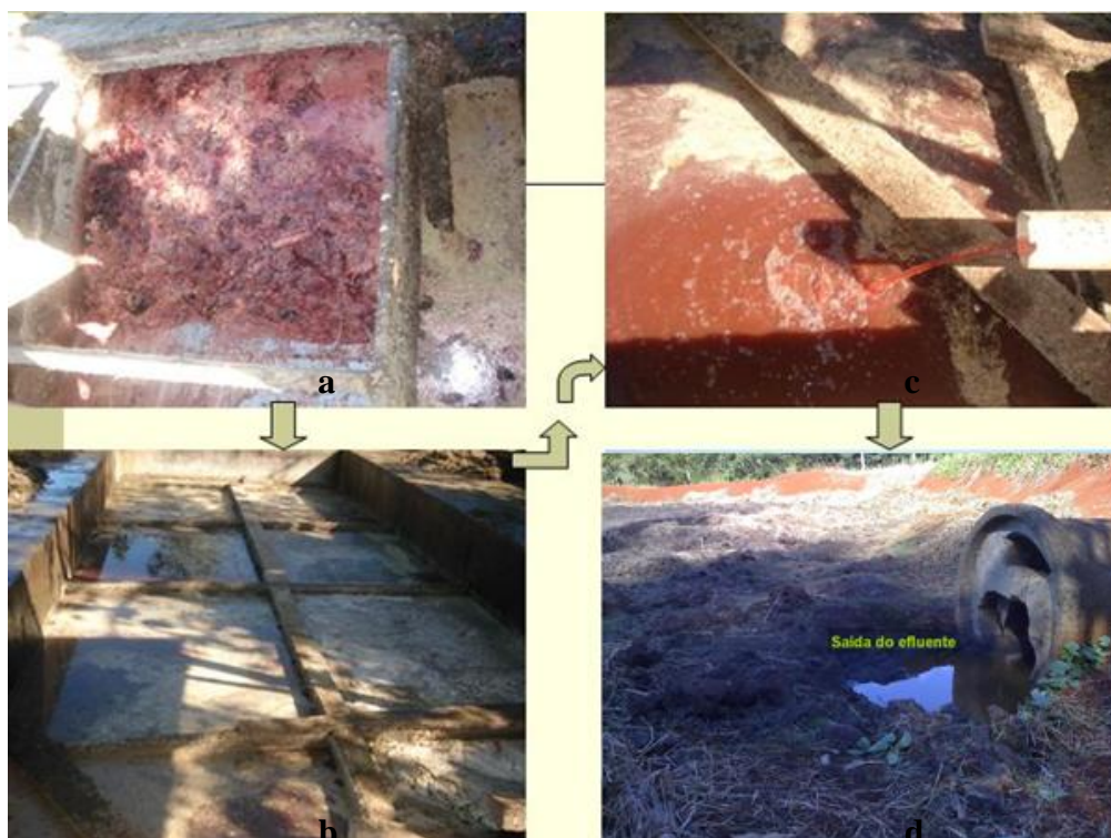
Figura 2. Sistema de tratamento do frigorífico: a) caixa de gordura; b) tanques de sedimentação; c) tubulação de saída dos tanques de sedimentação; d) saída da 1ª lagoa anaeróbia.
