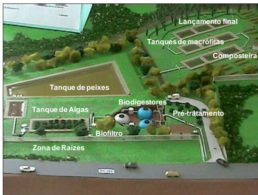
Figura 01- Esquema da ETE Caxixe com todas as etapas do tratamento (Fonte: O Instituto Ambiental)
