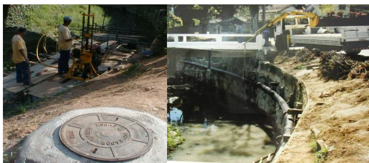
Foto 03 –Perfuração para Atirantamento e colocação da Tubulação em PEAD.
