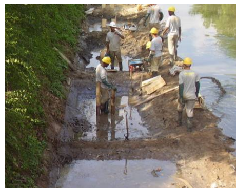
Foto 11 – Vista da cravação de estaca
