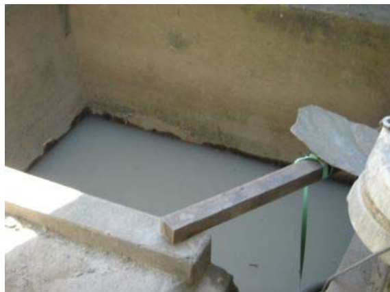
Figura 5: Quarta etapa: Produção de lama devido a presença de água durante corte com disco das chapas
