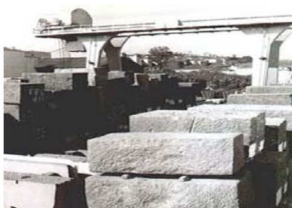
Figura 3: Segunda etapa do processo: transformação das rochas em blocos
