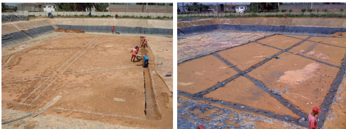
Figura 5: Etapas da execução do sistema de drenagem de biogás da base da lagoa facultativa.
