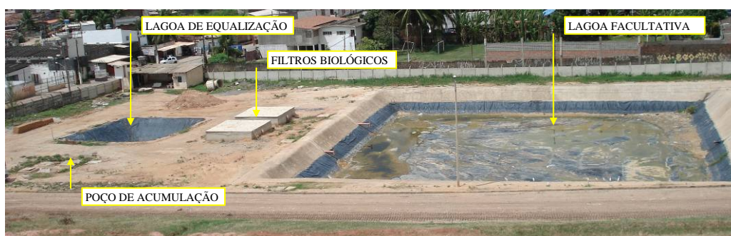
Figura 3: Estação de Tratamento de Lixiviado do Aterro de R.S.U. em construção
