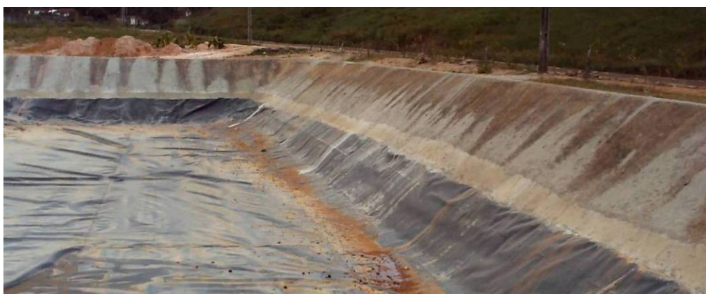
Figura 6: Finalização da instalação da manta após execução do sistema de drenagem de biogás
