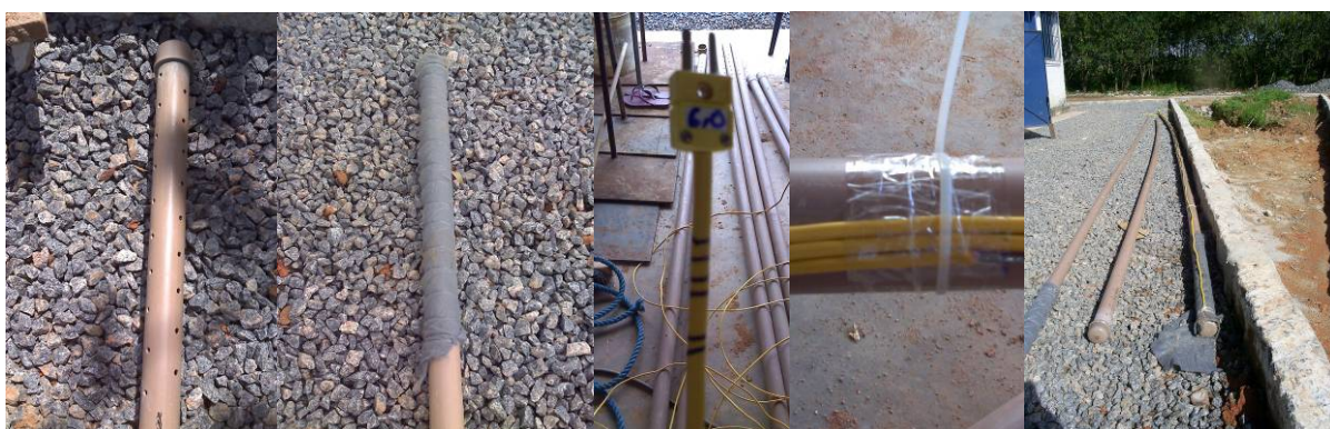
Figura 02 – Instalação dos Piezômetros e Termopares na célula experimental de RSU da Muribeca-PE.
