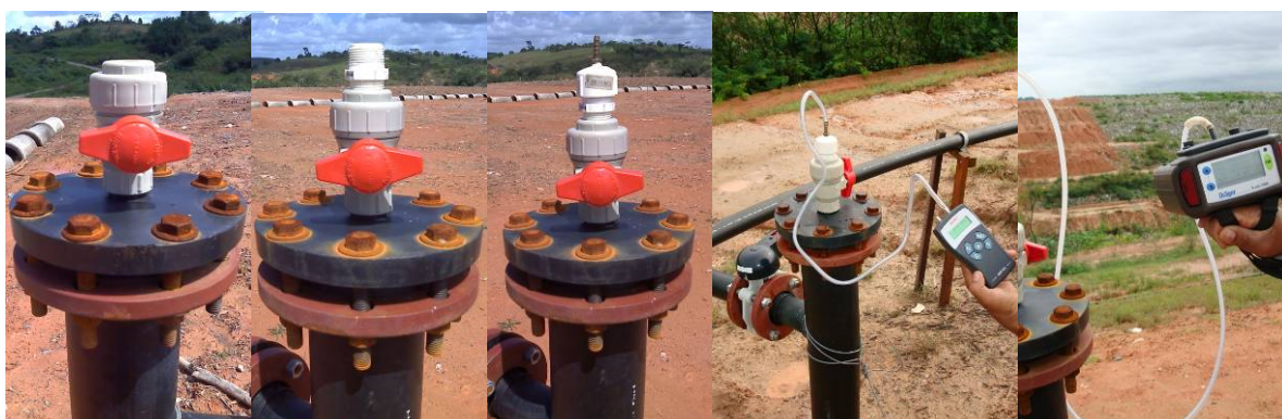
Figura 4 – Instalação de pontos para monitoramento dos gases ao longo da tubulação
