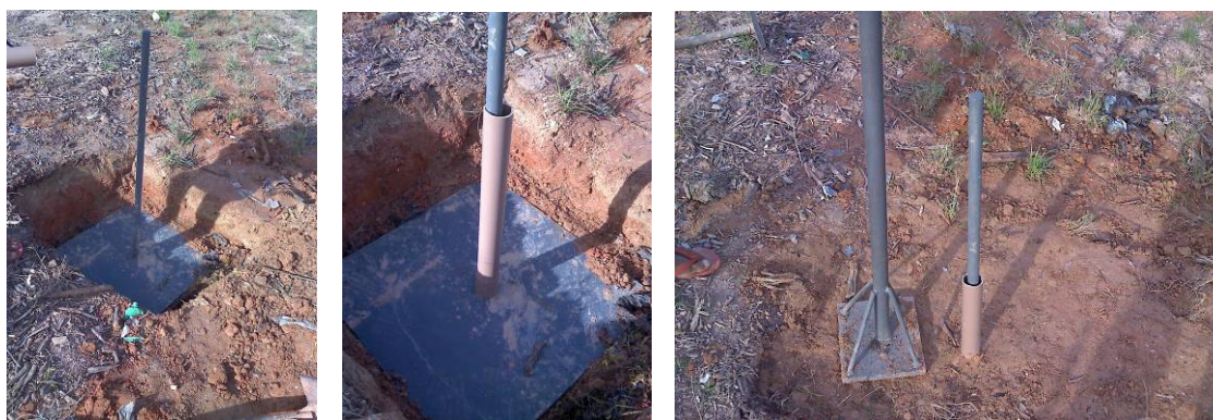
Figura 01 – Instalação dos Marcos Superficiais na célula experimental de RSU da Muribeca-PE.
