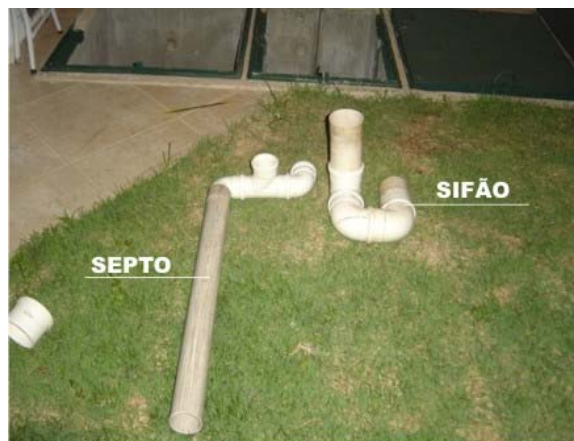
Figura 3: Montagem do septo de chegada e sifão do extravasor.
