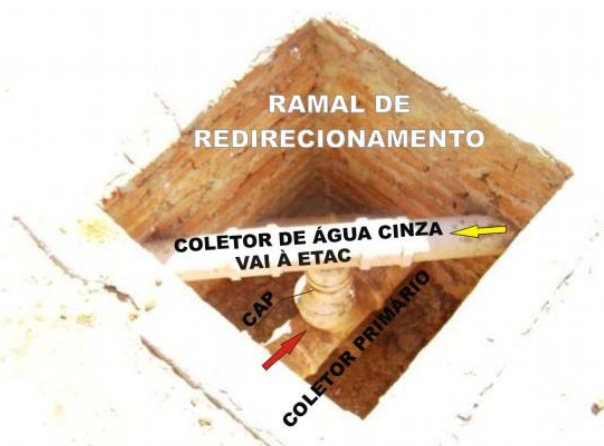
Figura 6: Ramal de redirecionamento ilustrando o sistema ligado.
