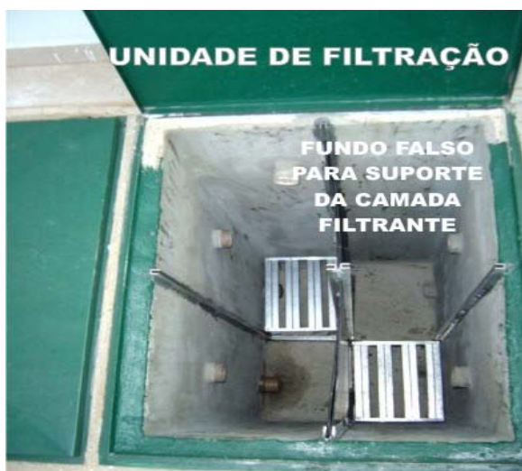
Figura 7: Montagem da unidade de filtração compartimentada.
