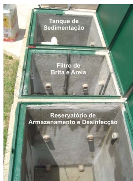
Figura 2: Unidade de tratamento do sistema de reúso de águas cinza.
