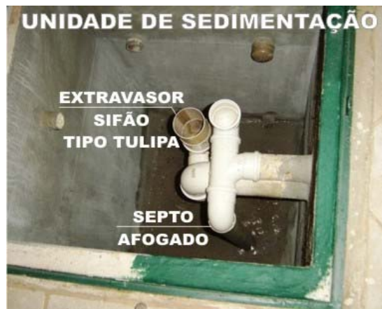
Figura 4: Unidade de sedimentação com septo afogado e sifão extravasor montados.
