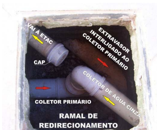
Figura 5: Ramal de redirecionamento ilustrando o sistema desligado.
