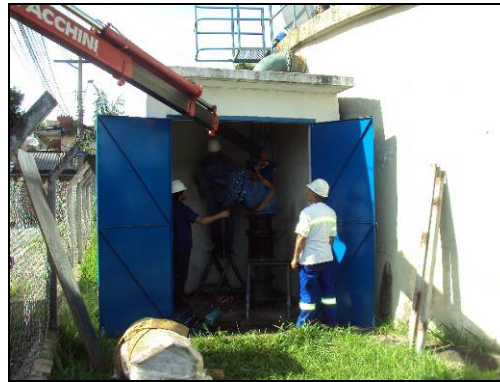
Figura 4: Instalação da válvula
