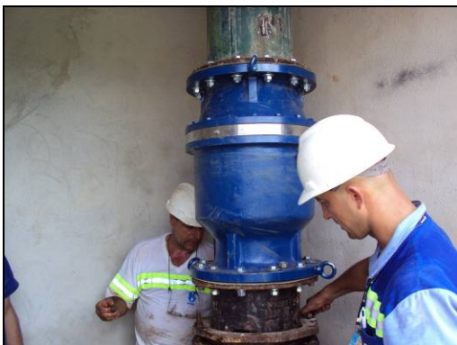
Figura 5: Instalação da válvula
