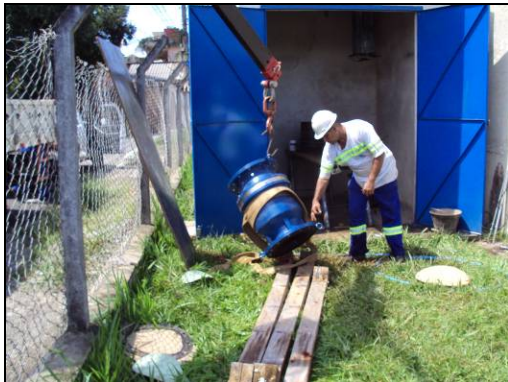
Figura 3: Instalação da válvula
