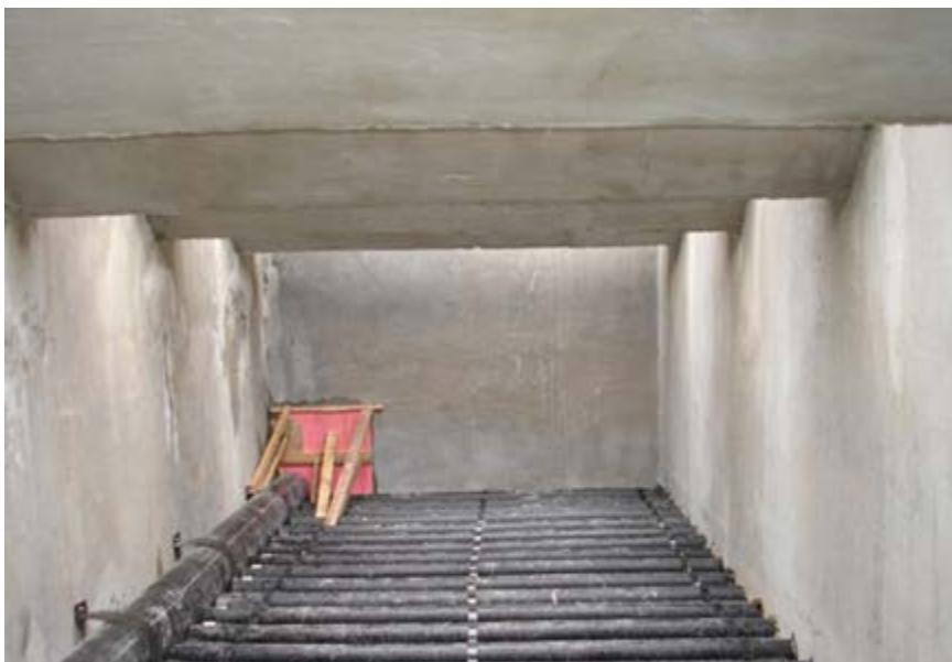
Figura 3: Sistema de lavagem com ar e água montado no interior do filtro.
