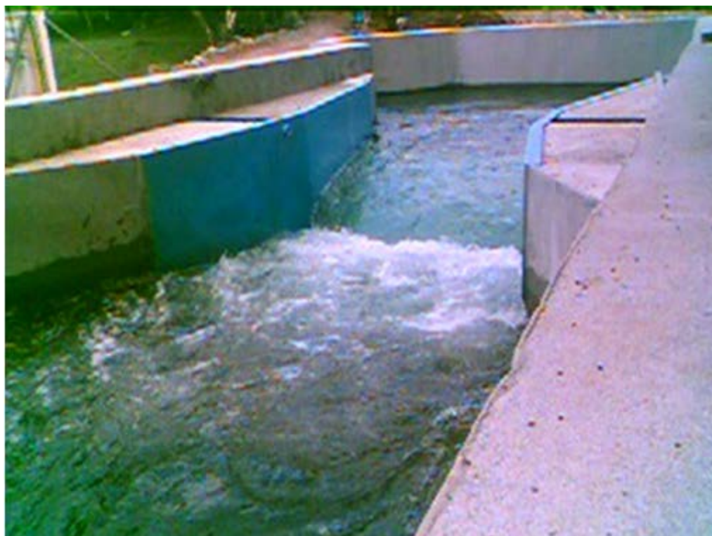
Figura 2: ETA do Parque da Imprensa: novo Parshall.
