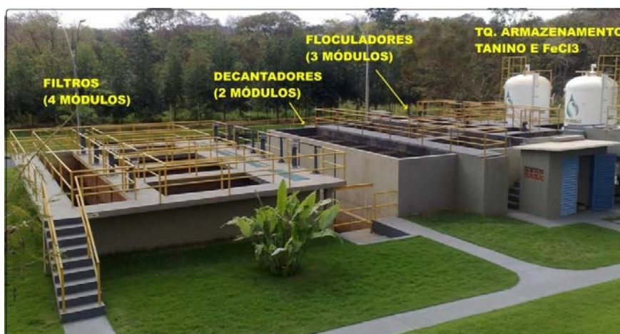
Figura 5: Foto da vista do sistema físico-químico.
