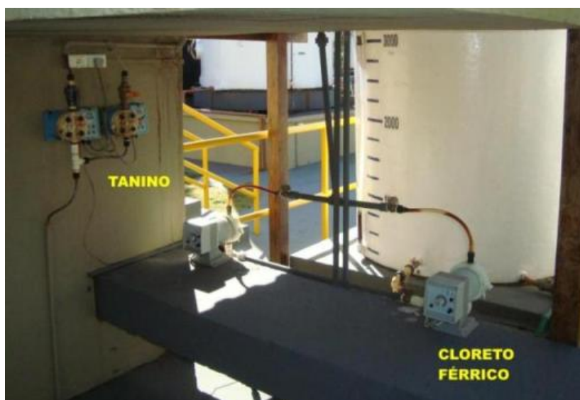
Figura 9: Bombas dosadoras (1+1 reserva) para aplicação de solução com tanino na entrada do sistema de floculação e bombas dosadoras (1+ 1 reserva) para aplicação de solução com cloreto férrico na calha Parshall a jusante do desarenador.
