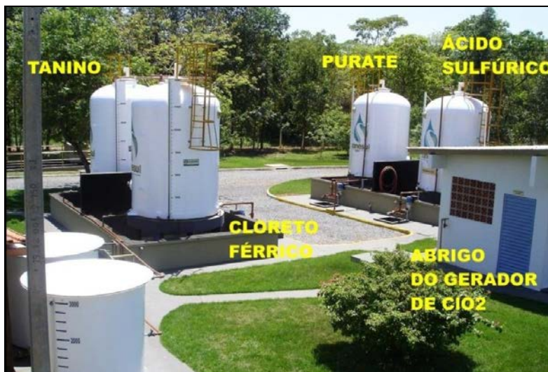
Figura 10: Foto da vista dos tanques de fibra de vidro utilizados para armazenamento de produtos.
