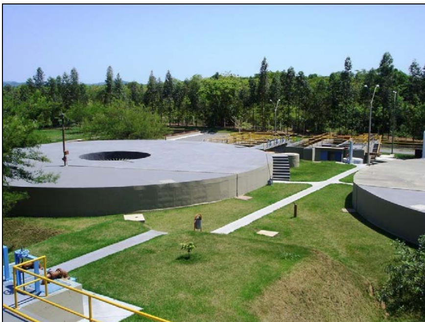
Figura 4: Foto da vista dos reatores anaeróbios (primeiro plano) e das unidades de floculação, decantação e filtração aos fundos.
