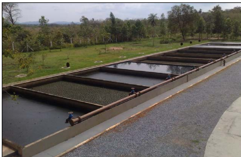
Figura 7: Foto da vista dos módulos de leito de secagem de lodo.
