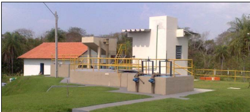
Figura 3: Estrutura do tratamento preliminar com gradeamento, desarenador ciclônico com compressor “air lift”, caçamba “brooks”, calha Parshall W=9” com sensor ultra-sônico e sinal para registrador de vazão do esgoto bruto e bomba dosadora de solução de cloreto férrico.
