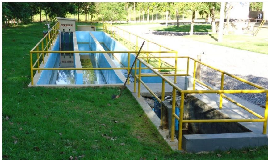
Figura 6: Foto da vista do tanque de contato com uma calha Parshall na entrada para efeito de controle e medição de dosagem de solução com dióxido de cloro como desinfetante.
