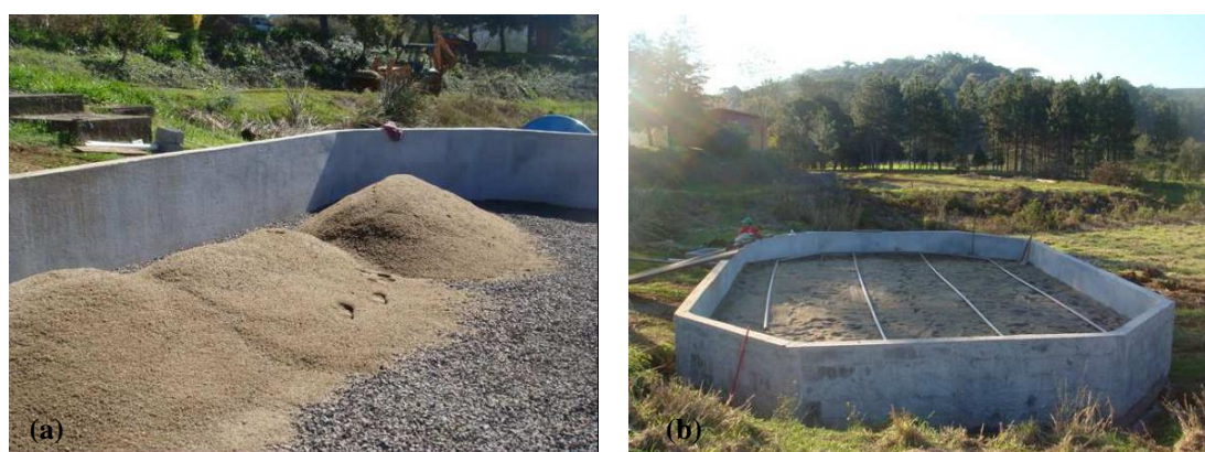
Figura 2: Detalhe do assentamento do material filtrante no FPMV.
