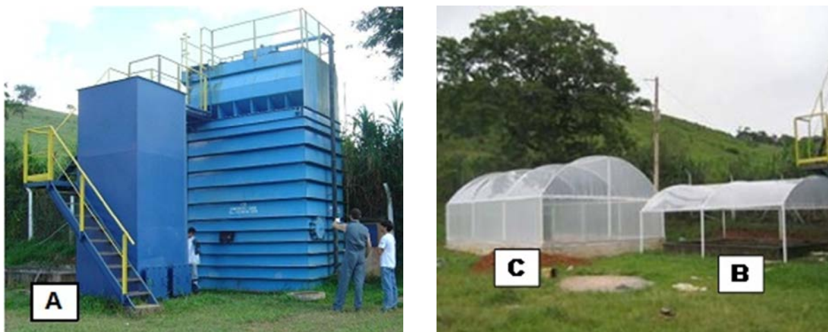
Figura 1 - Unidade Integrada de Tratamento e Utilização de Esgotos Sanitários da Viçosa, Viçosa – MG. (A) Reator UASB e biofiltro aerado submerso. (B) Leitos de secagem. (C) Estufa agrícola.
