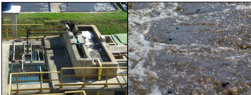
Figura 3: Unidade experimental de Lodos Ativados de Leito Móvel
