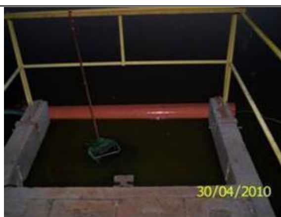
Figura 6 – Tubo para retenção de sobrenadante no vertedouro da lagoa facultativa.
