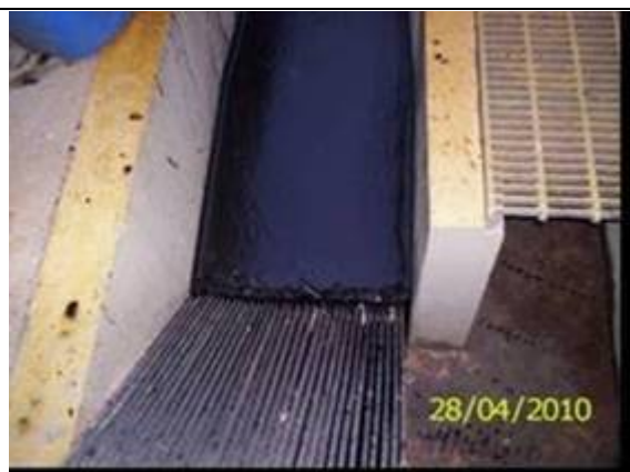
Figura 2 – Óleo retido no gradeamento da ETE
