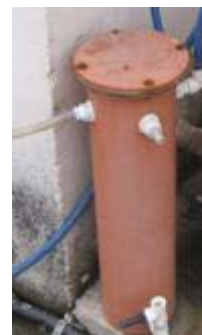
Figura 2: Detalhe da caixa de dissipação instalada após o reator UASB
