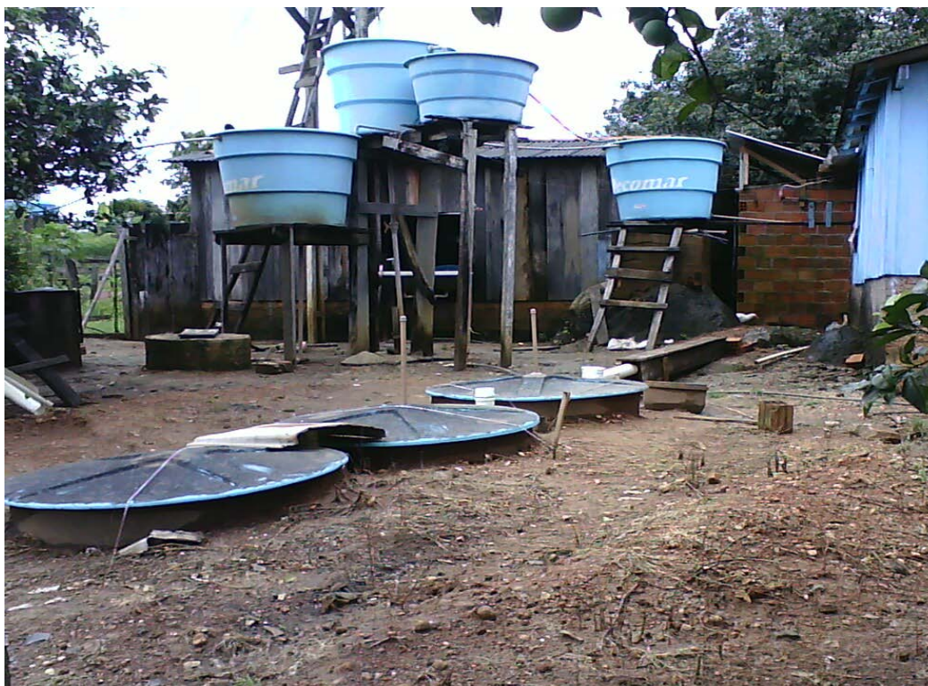
Figura 3. Sistema de fossa séptica biodigestora instalado.
