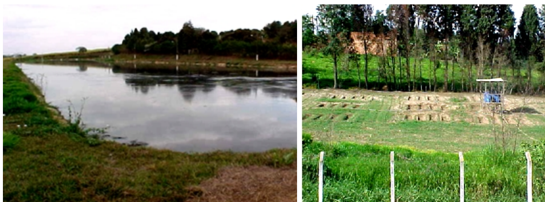
Figura 2: Lagoa anaeróbia que recebe o esgoto doméstico do bairro da Graminha em Limeira (SP) e terreno ao lado onde foi instalada a pesquisa.
