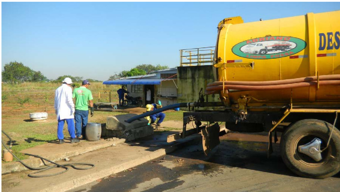
Figura 02 – Caixa de recebimento de caminhão limpa fossas e casa de controle.
