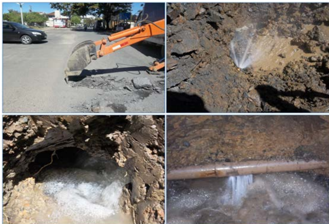
Figura 4: Fotos de um dos vazamentos encontrados. Fonte: COPASA
