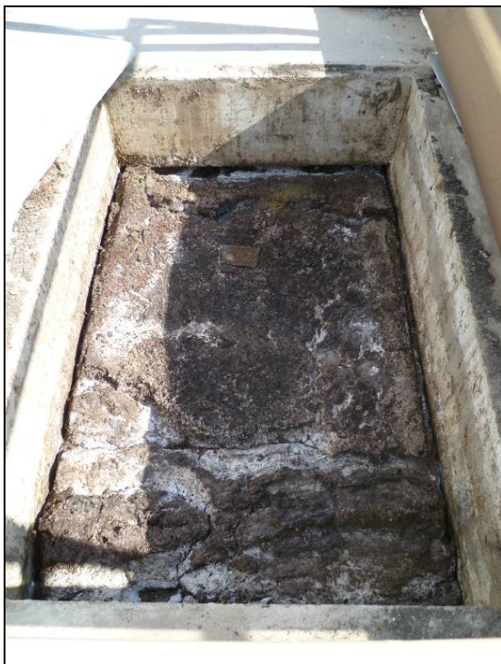
Figura 2: Escuma acumulada na superfície do separador trifásico.
