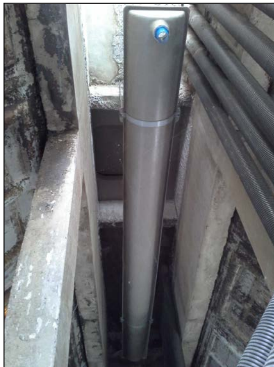
Figura 3: Calha para remoção de espuma no interior do separador trifásico.
