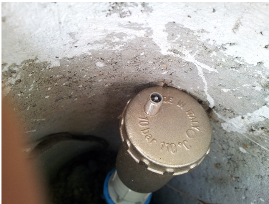
Figura 4: Ventosa instalada na rede de distribuição
