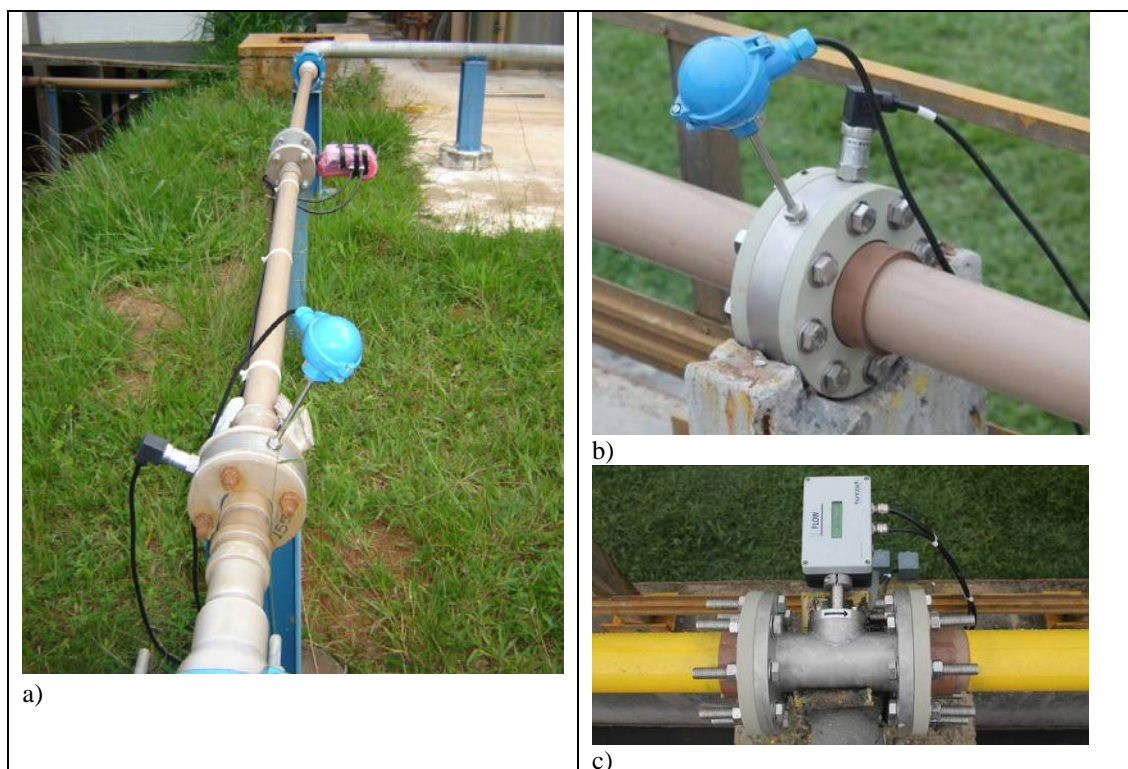
Figura 5 – Medição da vazão de biogás: a) Linha de gás com os medidores; b) Flange com medidor de pressão e temperatura; c) Medidor de vazão de biogás
