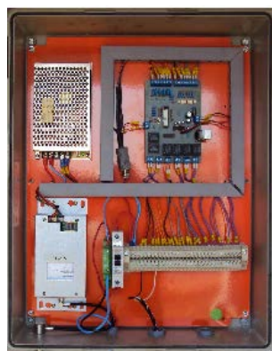
Figura 1: Painel de automação, com CLP marca SANEAGO, rádio modem e fonte.
