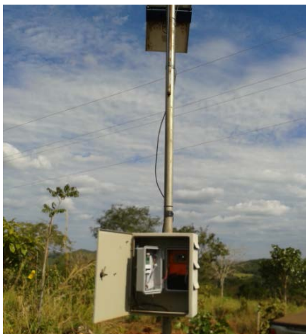
Figura 3: Pannel de automação alimentado por placa solar
