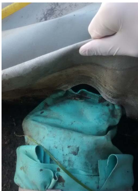
Figura 4 - Detalhe do vazamento no digestor 1
