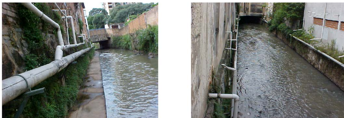
Figura 4 – Tubos de PVC reforçados com ferrocimento operando como interceptores de esgoto sanitário, segundo Silva (2004).
