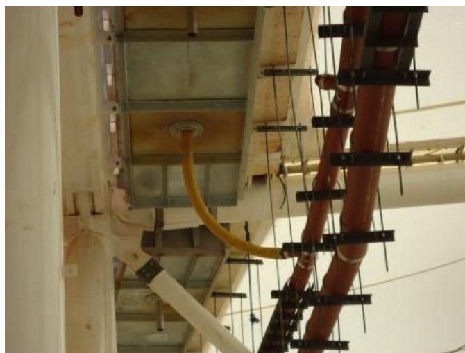
Figura 7: Suportes em vergalhão e cantoneiras em aço maciço projetados e fabricados para apoio dos tubos instalados no sentido horizontal.
