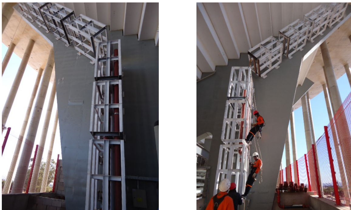
Figura 12: Suportes em aço para as descidas de 9 tubos DN100mm no sentido vertical e no sentido diagonal.
