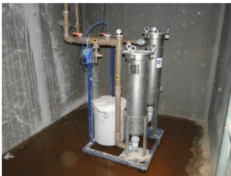
Figura 13: Filtro de areia locado nos reservatórios que recebe água diretamente da cobertura.
