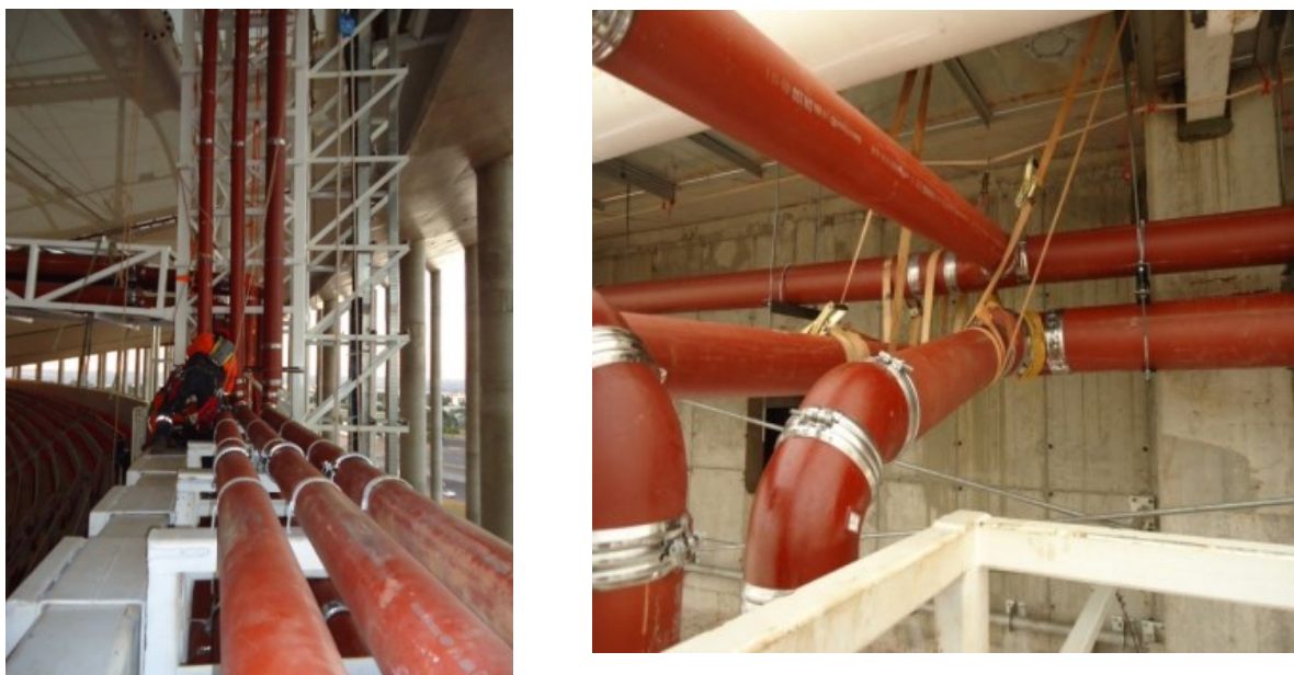
Figura 5: Coletores horizontais e verticais para o transporte da água pluvial situados logo abaixo da cobertura, transição dos tubos executados com suportes e abraçadeiras.
