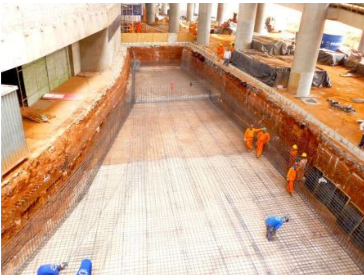
Figura 15: Imagem da construção de um dos 4 reservatórios de 350m 3 .
