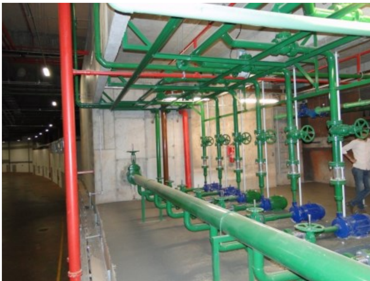
Figura 18: Sistema de recalque de água tratada com um conjunto de 8 unidade de moto bombas para o recalque da água tratada, sendo sempre uma reserva da outra.
