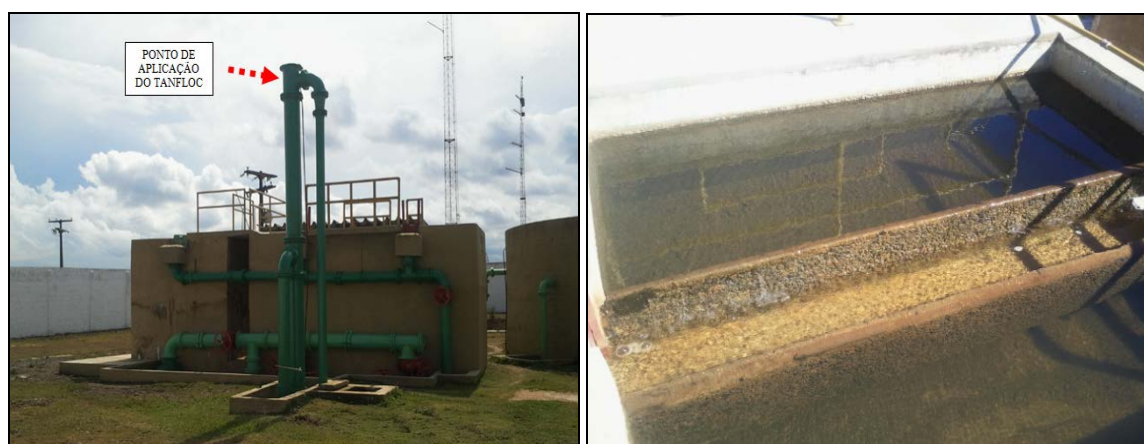
Figura 1: Filtro ascendente utilizado na ETA de Tapiramutá.
