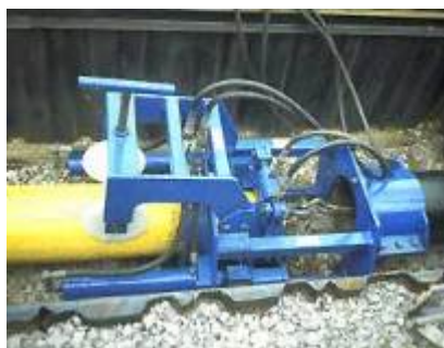
Figura 10: Inserção por Swagelining.
