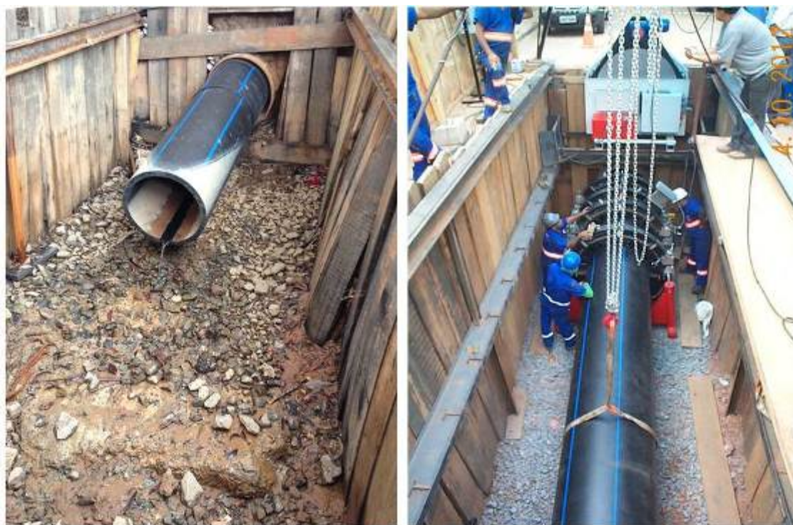
Figura 7: inserção de tubos ou slippilining, na Adutora Jd. América-Lapa.
