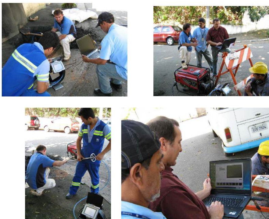
Figura 13: Inspeção televisiva da rede o término da limpeza da tubulação.
