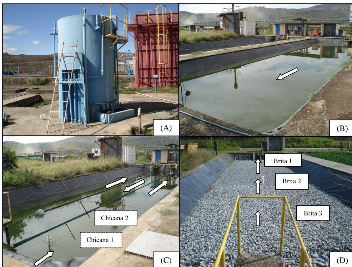
Figura 3 - Unidades do sistema de tratamento de esgoto. Reator UASB (A); Primeira lagoa da série (L1); Segunda lagoa da série com chicanas (L2C); (D) Filtro grossoiro de Brita (FG).
