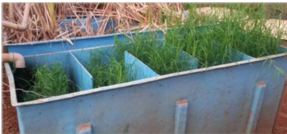
Figura 2: Sistema alagado construído utilizado no pós-tratamento dos efluentes da suinocultura e cultivado com capim-tifton 85.
